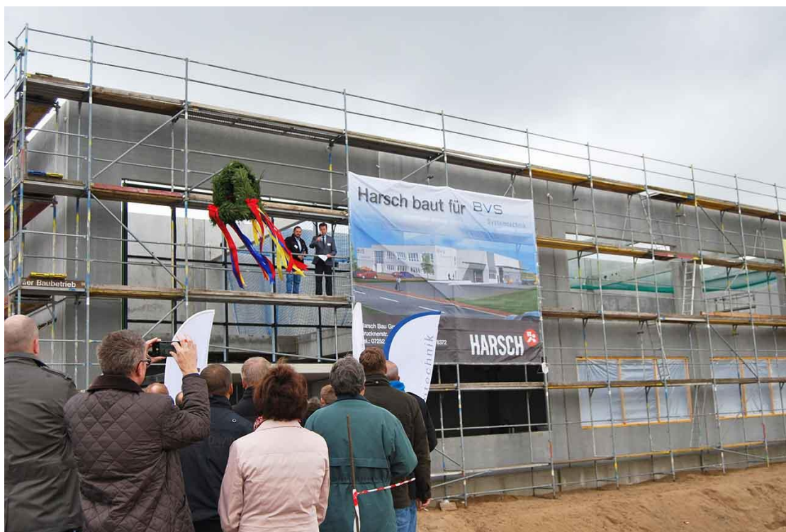
Einweihung des Verwaltungsgebäudes seitens Rudolf Harsch und Markus Öchsle, Harsch Bau. Bild: Invest in Mecklenburg Vorpommern.
